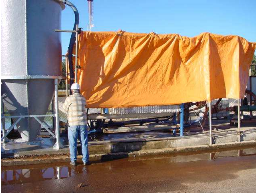
Instalação da unidade de desaguamento
